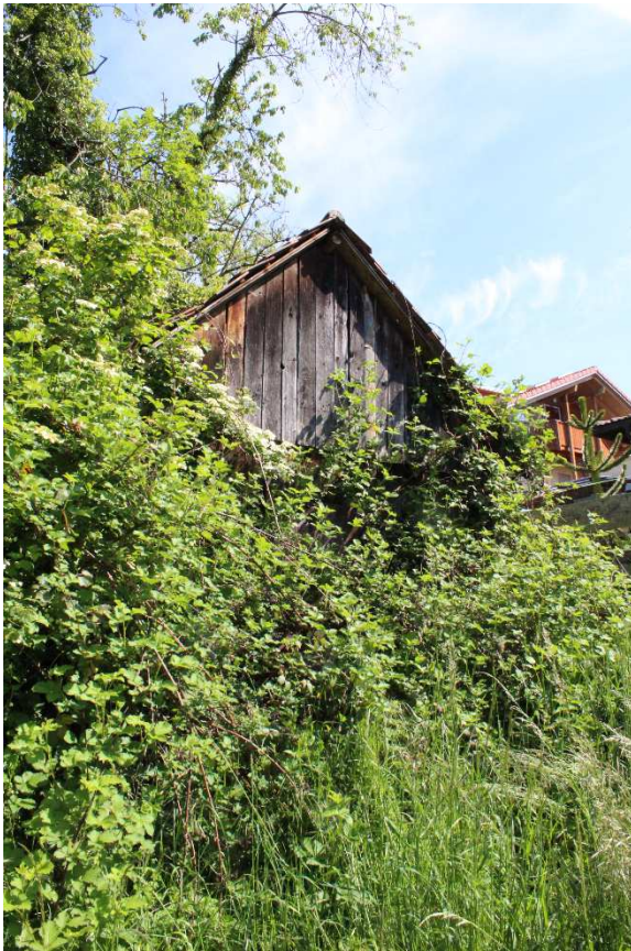
Die alte, halb verfallene und überwucherte Brunnenstube im zentralen Bereich der Fläche.
