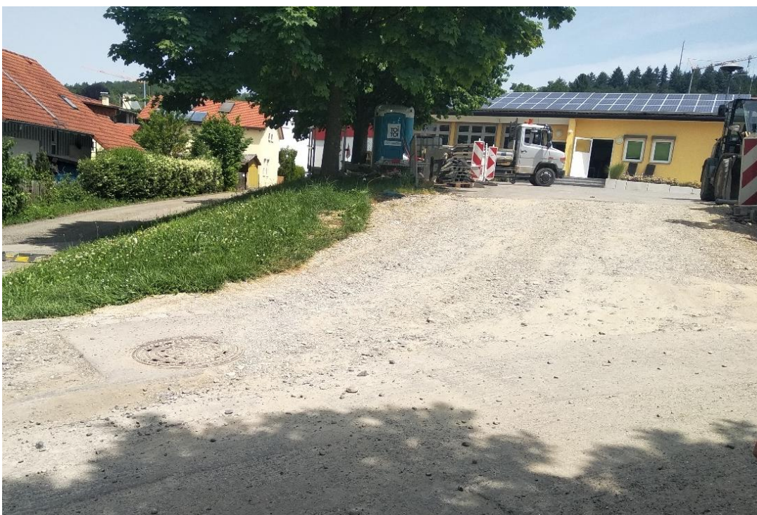
Abbildung 21: Umbauarbeiten in der Schulstraße und der Einfahrtsituation zum Kinderhaus und dem Parkplatz
