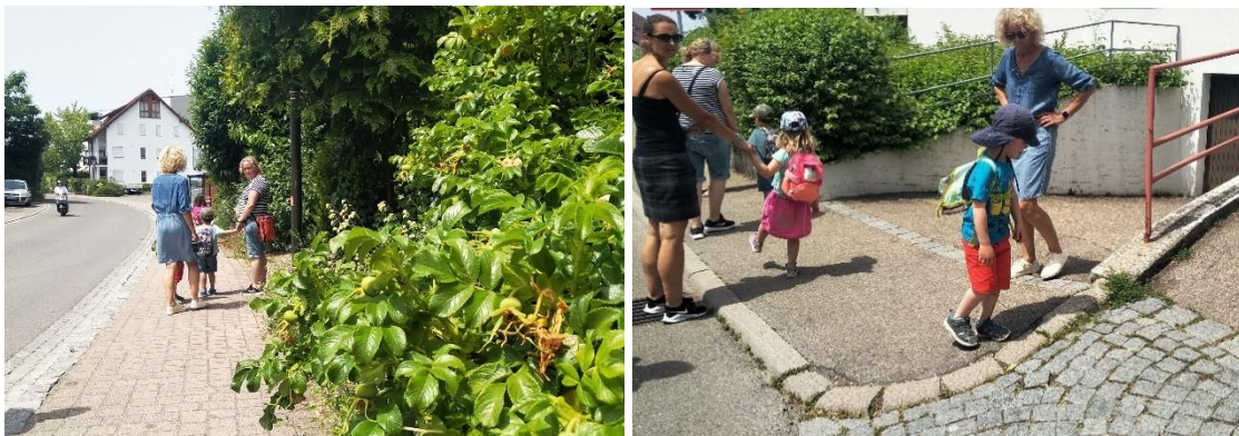
Abbildung 29: Baitenhauser Straße/ Ortsstraße Qualitätsminderung durch Bewuchs und Gehwegoberfläche
