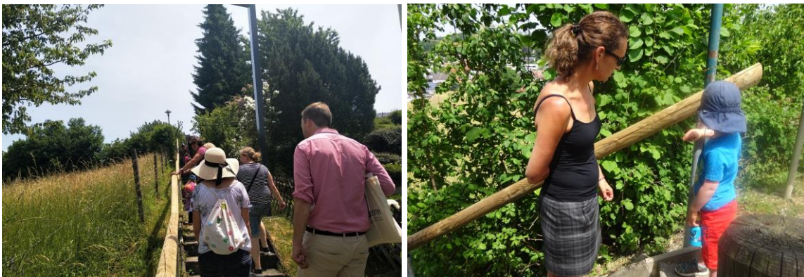
Abbildung 27: Treppenanlagen mit Beleuchtung und neuem Handlauf
