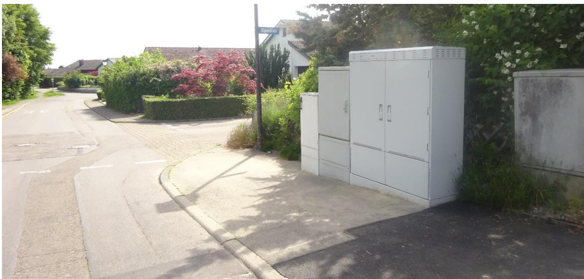
Abbildung 37: Einbauten im Seitenraum (Gehweg) - hier mit ausreichend Restbreite
